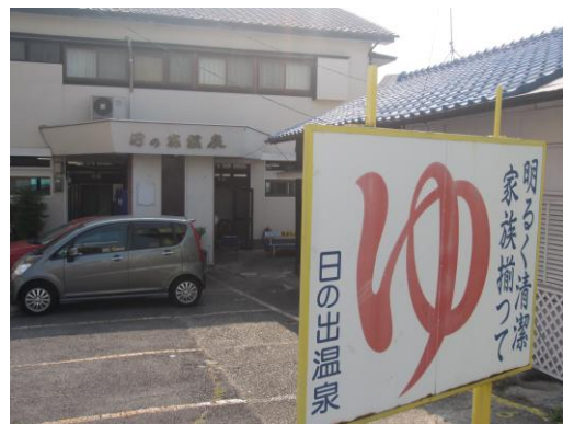
日の出温泉も建て替えられているが、1 階が半地下の共同浴場、2 階が地区の自治公民館という構造は今も変わらない。
